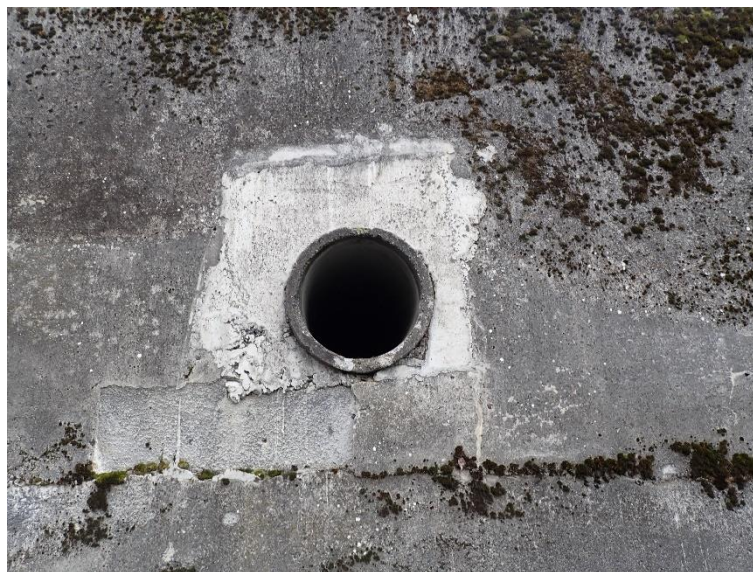
Figure 20 : Ouvrage traversant de diamètre 500 mm du tronçon GC 36.3
