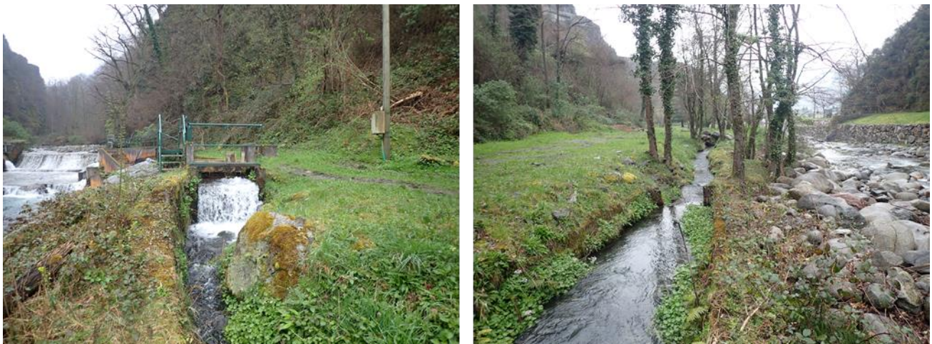
Figure 4 : Canal en haut de berge du tronçon GC 29.1 : vue vers l'amont à gauche et vers l'aval à droite
