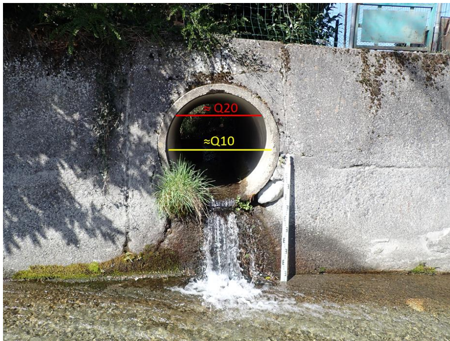
Figure 17 : Ouvrage traversant de diamètre 1000 mm du tronçon GC 40.4 et niveaux approximatifs des crues Q10 et Q20
