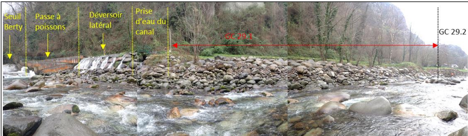
Figure 3 : Vue du tronçon GC 29.1 depuis la rive droite (assemblage de photos)
